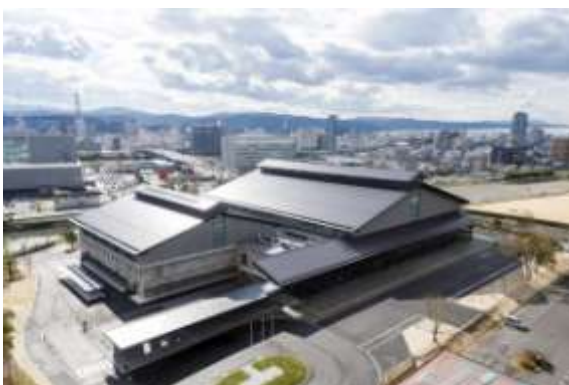
完成！ (平成 27 年 12 月)
